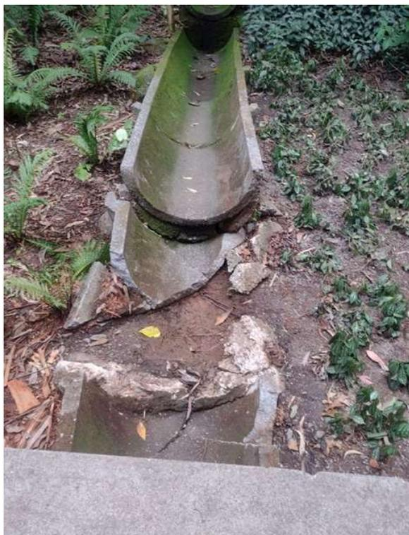
**Figura 165 - MANUTENÇÃO DA CANALETA DE CONCRETO QUEBRADA (DEPOIS)**
